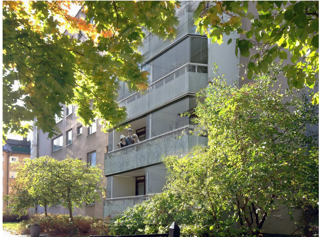
Fasad mot öster och gården efter balkongombyggnad
