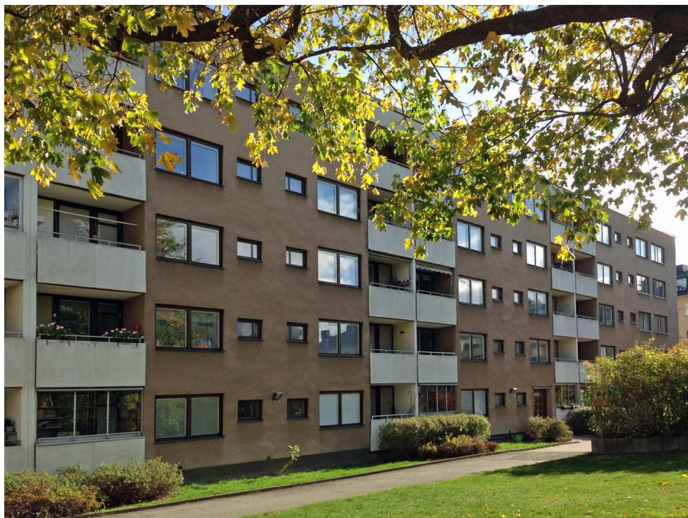
Hus 8, befintlig gårdsfasad mot väster.
