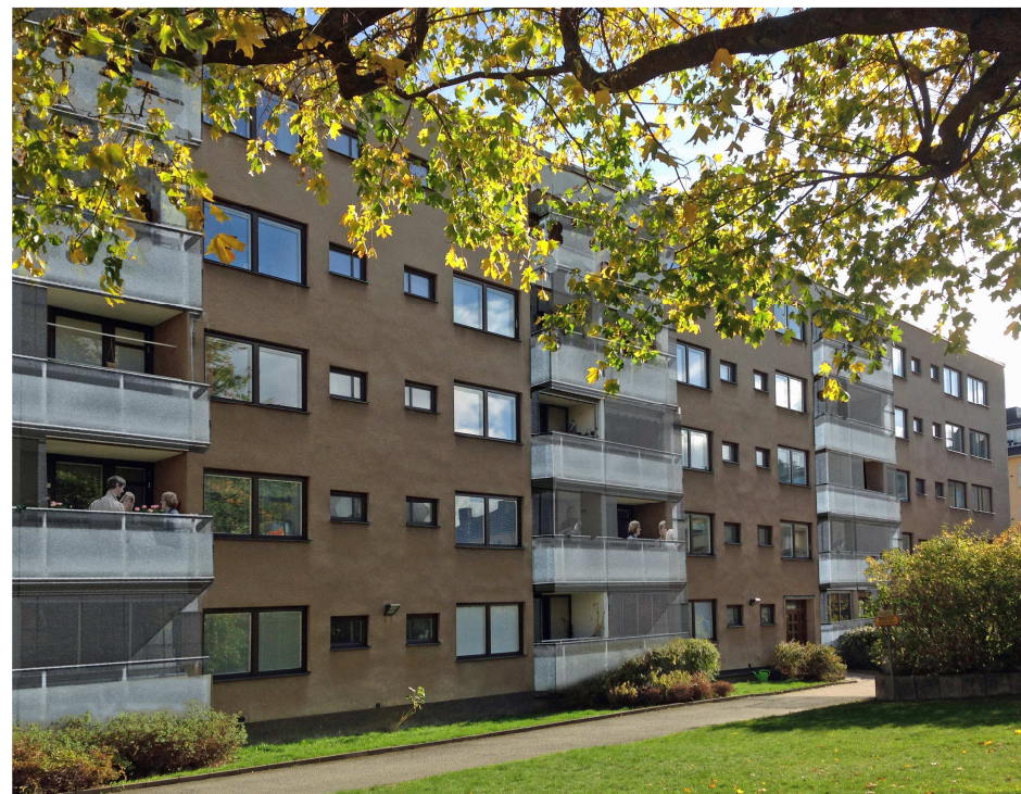
Gårdsfasaden efter balkongombyggnad.
